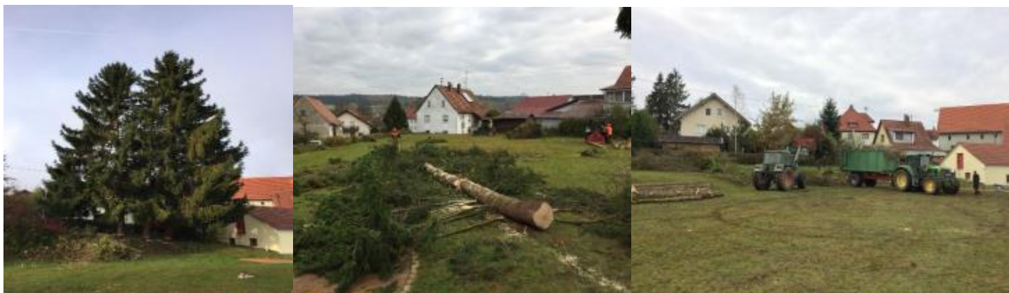
„Erfolgreicher Kahlschlag in der Ortsmitte von Edelbeuren“ - erster Arbeitseinsatz für das neue Dorfgemeinschafts-/Feuerwehrhaus Edelbeuren
